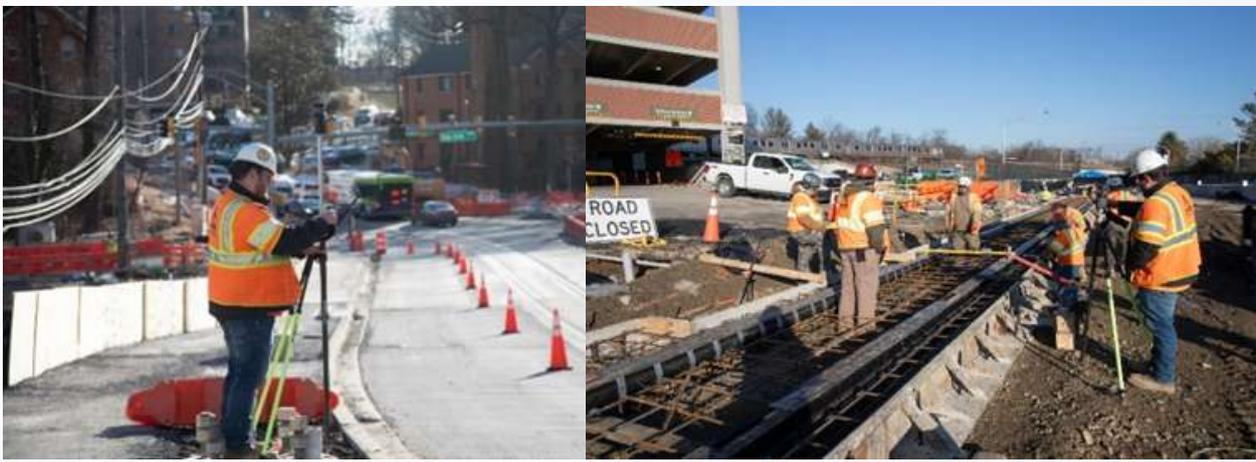
**Figura 5. Toma de datos de la base del poste de Luz (izq.) e instalación de rieles directamente al concreto (der.).**
