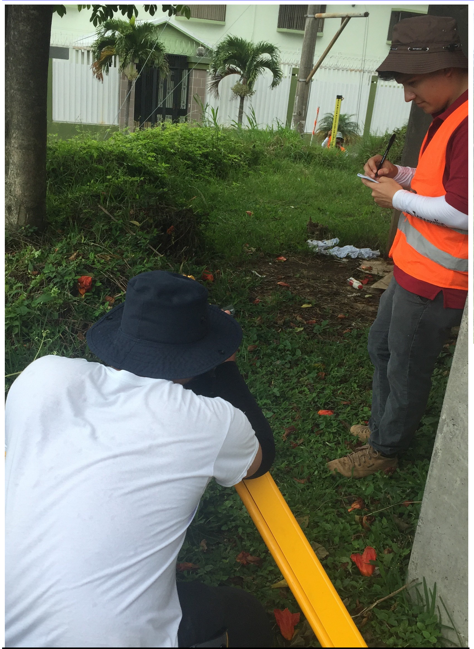
FIGURA 4. NIVELACIÓN DE ESTACIÓN CRLP.
